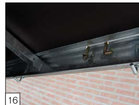
16 Optie: boutbare haken aan de onderzijde van zijrand.
